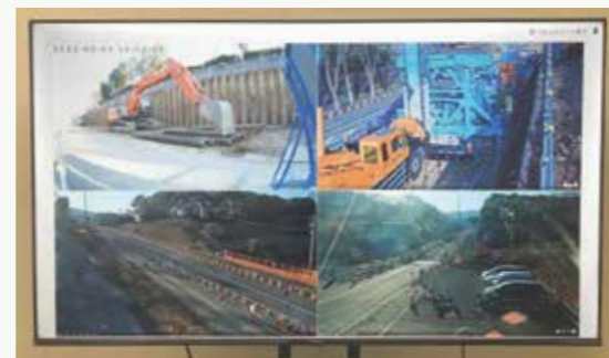
WEBカメラモニター（提供：鹿島建設株）
